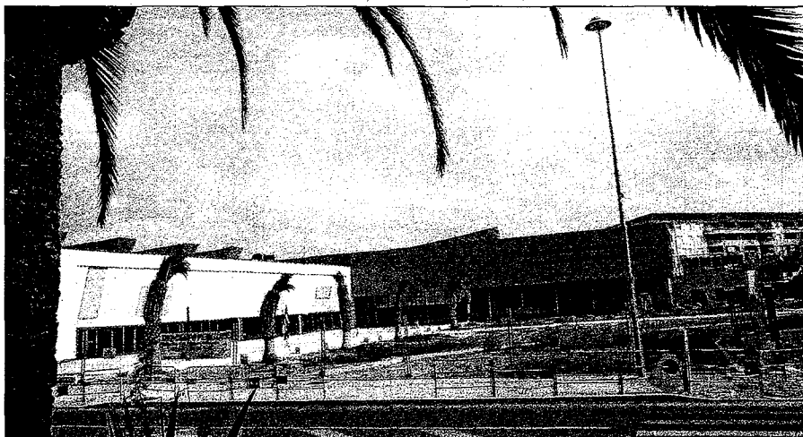
Le chantier du Palais des congrès Europa n'est pas totalement interrompu depuis le drame du 22 août qui a coûté la vie à un ouvrier, salarié d'une entreprise de Haute-Marne. (Photo Stéphane Goasguen)
