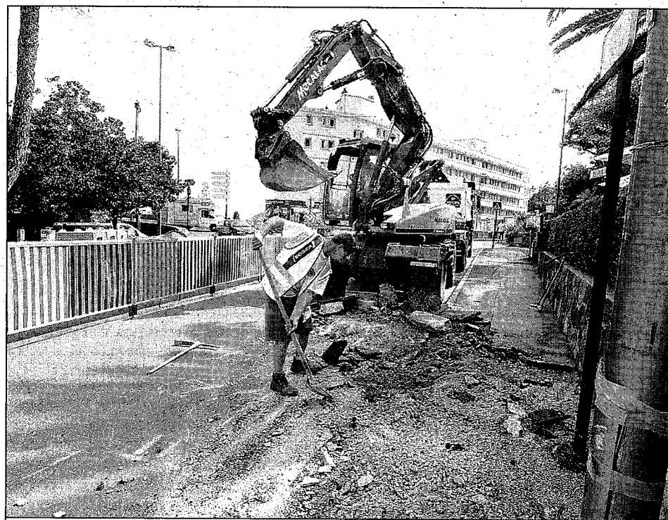
Le chantier de remplacement d'une canalisation devrait durer trois semaines.
