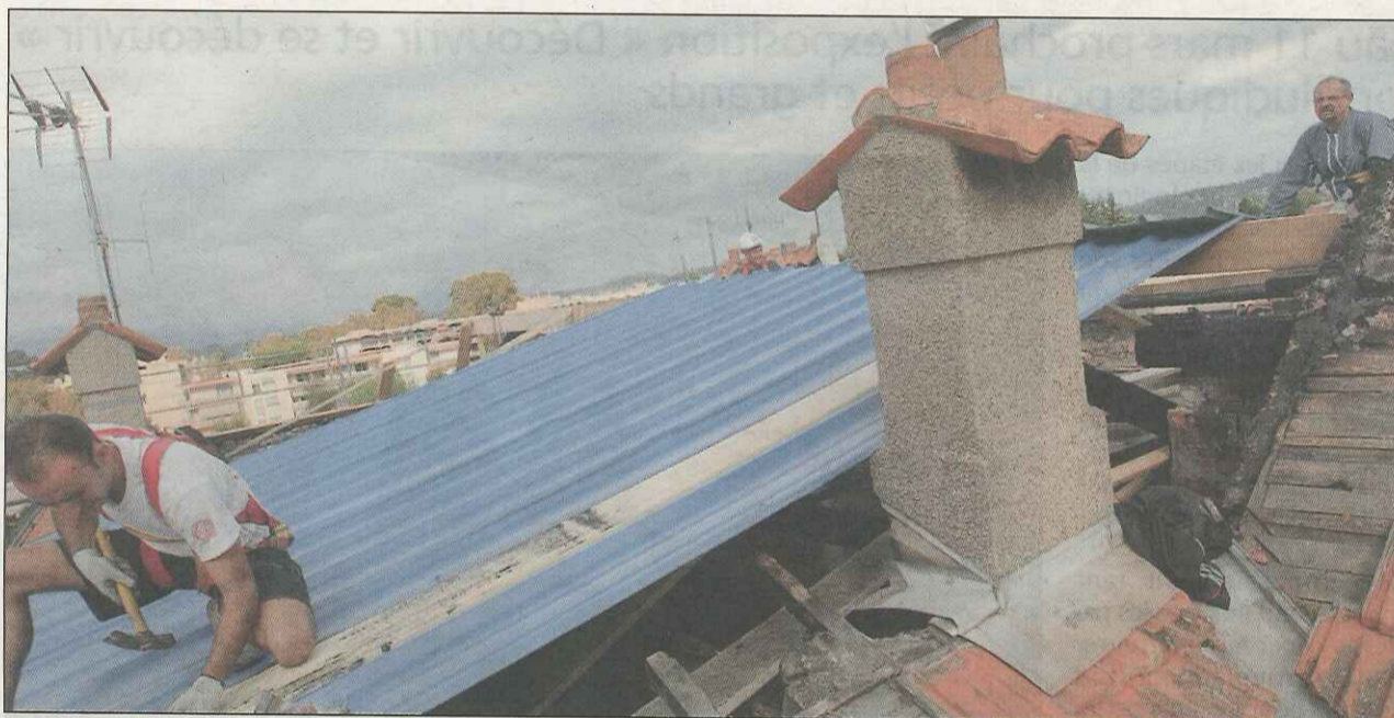
La toiture de l'ancien hôtel de ville a été partiellement détruite par les flammes jeudi soir. Dès hier matin, des ouvriers étaient à pied d'œuvre pour poser une couverture temporaire. (Photo Serge Haouzi)
