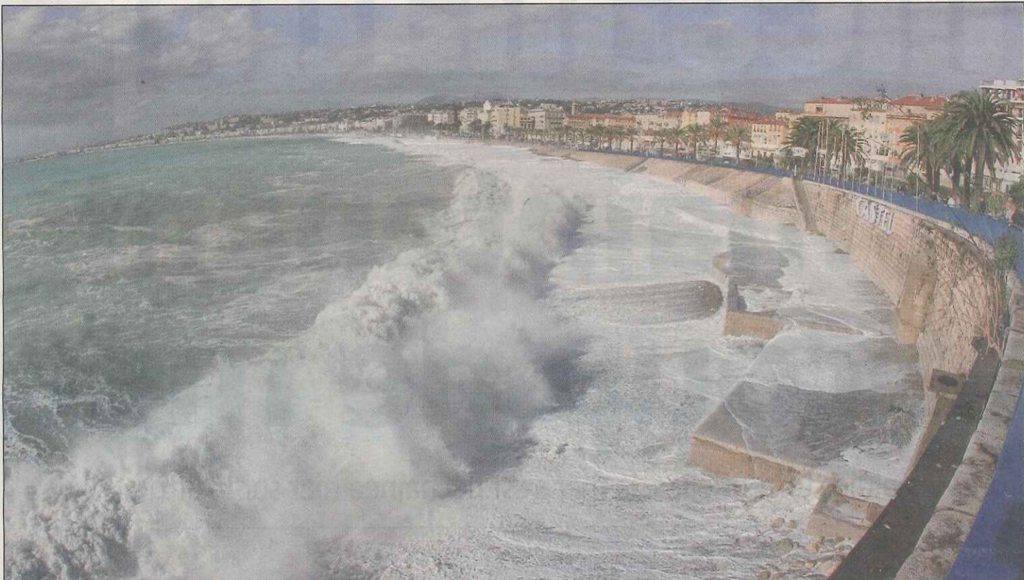
Hier, en milieu de journée, le quai des Ponchettes, à Nice, est frappé par des déferlantes hautes de six mètres.
